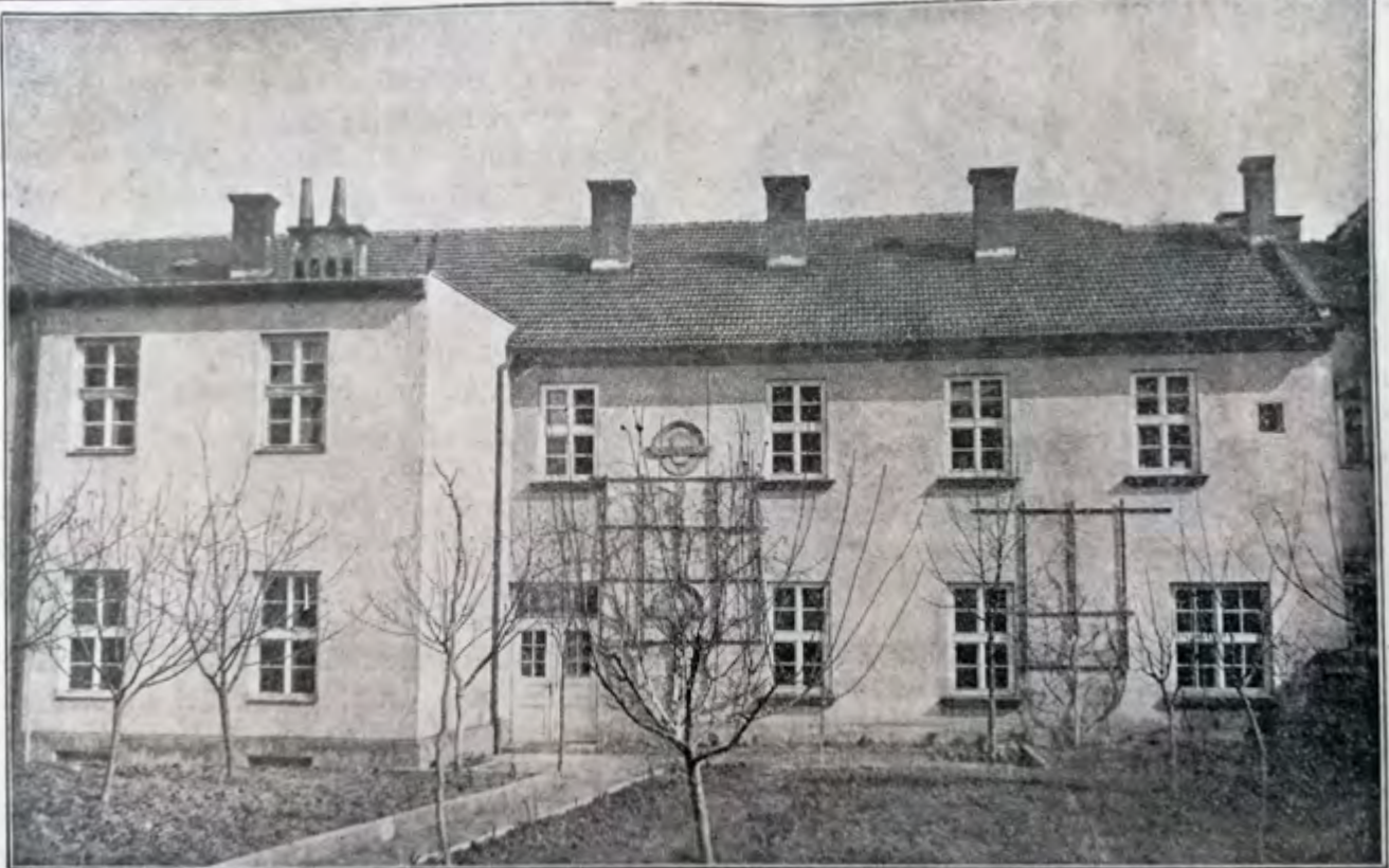
Pohled na Domov zezadu. Vlevo od přízemí po 2. okno do 1. patra je rovněž přístavba z r. 1931.
